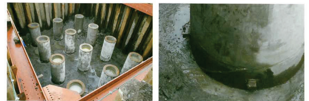
施工後の杭頭部掘削状況
