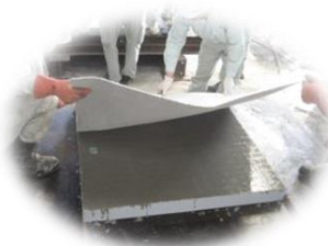
防草シートの貼り付け
