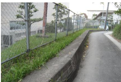
草とめ～る 400施工前の状態
