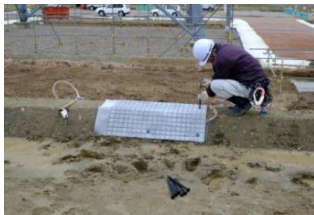
①のり肩設置状況
