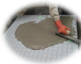
FRP製型枠にGRCを流し込む
