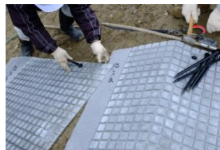
②マットジョイント部
