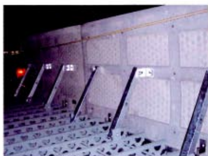
④PCF版の設置完了
