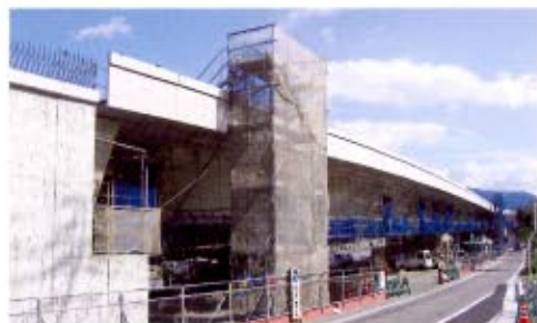
国土交通省四国地方整備局(愛媛県内)での施工例(※)
