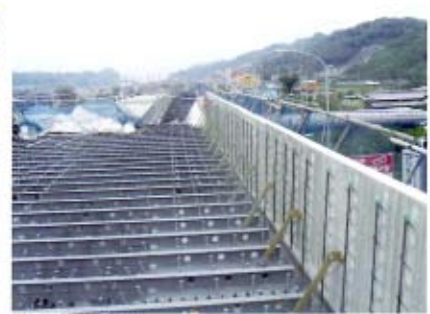
③設置状況
