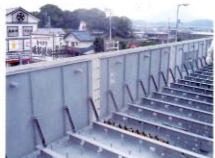
⑥(参考) 鋼製型枠
