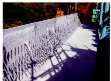
③設置状況 (内面)
