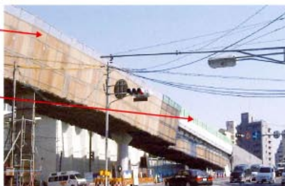
国土交通省中国地方整備局(広島県内)での施工例(※)
