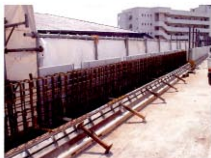
③設置状況2
