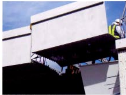
②合成床版敷設作業
