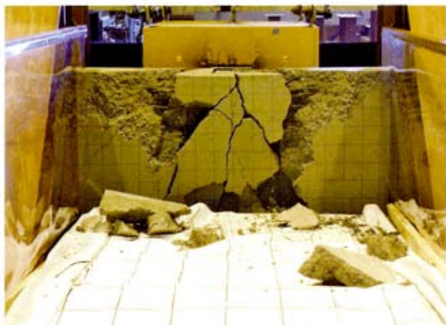
従来工法の壁高欄の破壊状況
