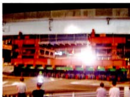
⑤桁運搬中（一括架設）
