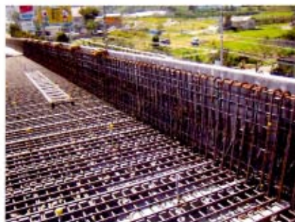
⑤配筋状況
