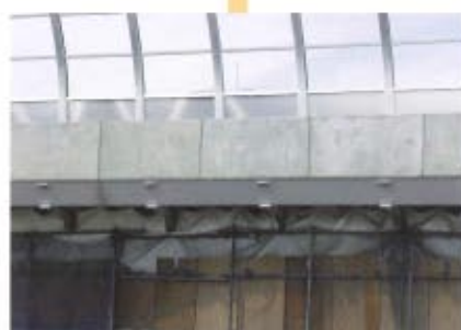
⑥ 施工完了です。
