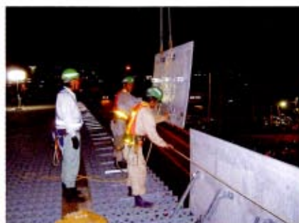
②設置状況1
