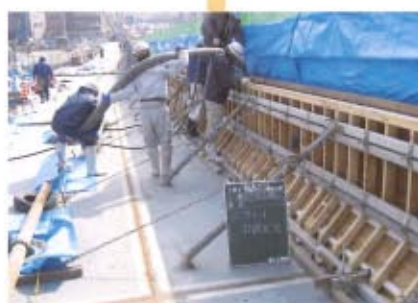
⑤ コンクリートを打設して、養生します。
