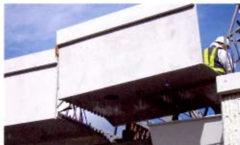
施工風景(合成床版に先付け施工)
