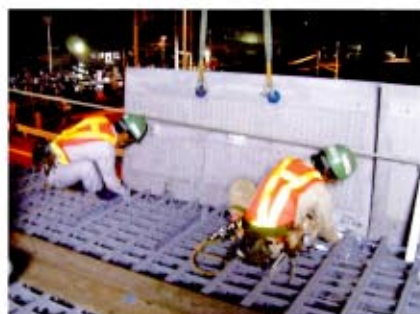
③設置状況2
