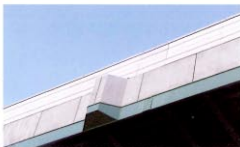
PCF壁高欄での施工例(※)
