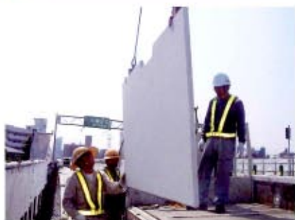
①取付作業
