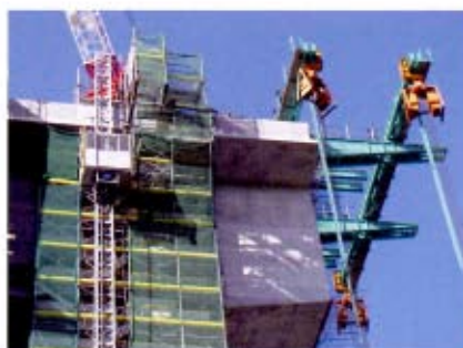
②場所打ち張出し架設
