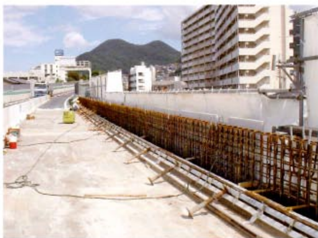
高欄の取り替え工事の施工例
