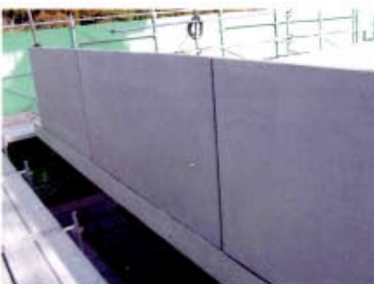
④設置状況 (外面)
