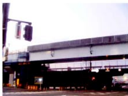
⑥架設完了
