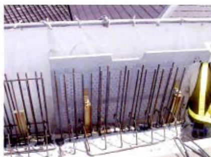
②設置状況1
