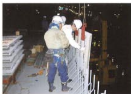
① クレーンでPCF版を吊り込み、設置します。
