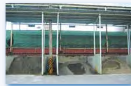
5. コンクリート材料 (砕砂・砕石) 細骨材 (砕砂) と粗骨材 (砕石) を骨材置場へ搬入します。
