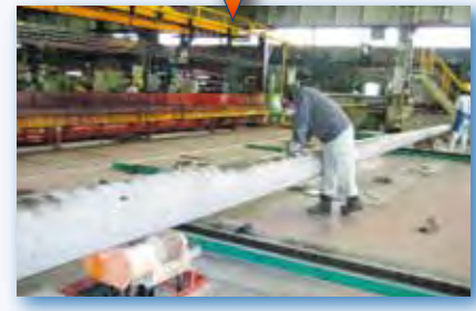
10. 脱型 (プレストレス導入) PC鋼線の緊張を解放する事により、製品にプレストレスの導入を行い、型枠から製品を取り出します。また、脱型と同時に各種表示、脱型検査を行います。
