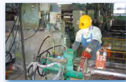
4. 鋼線緊張 型枠の一端に油圧ジャッキを取付け、PC鋼線を緊張し、型枠に固定します。
