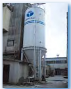
6. コンクリート材料 (セメント) バラセメントをセメントサイロに搬入、貯蔵します。
