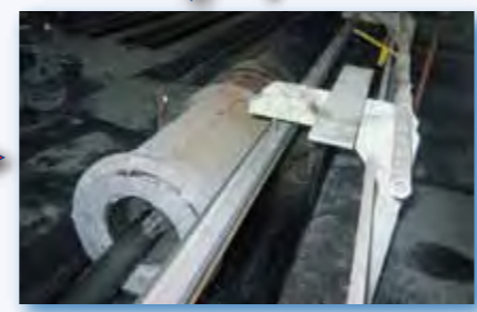
7. コンクリート製造・注入 コンクリート材料は所定の配合に従って正確に計量し、ミキサーで混練りします。鉄筋かごを組み込んだ型枠を台車に乗せ、コンクリートポンプにより自動的にコンクリートを注入します。
