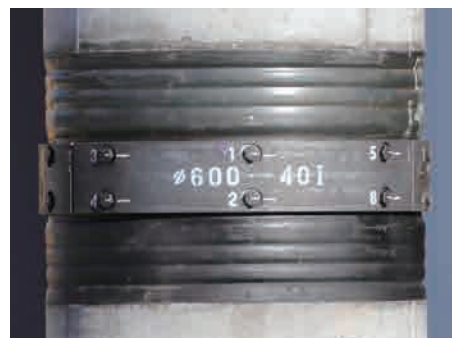
一次締め完了後、ボルト頭部からプレートにかけて 一本線でマーキングする。
